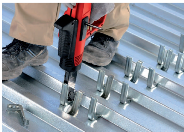
Conectores fijados mecánicamente
